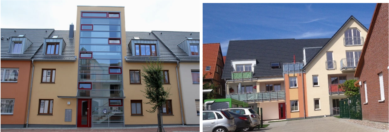
Stralsunder Straße 7 – Vorder- und Rückansicht Neubau nach Rückbau (Foto Vorderansicht: Gebäudewirtschaft Ribnitz GmbH)
