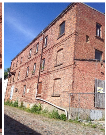
Wasserstraße Wassermühle Abriss 2016
