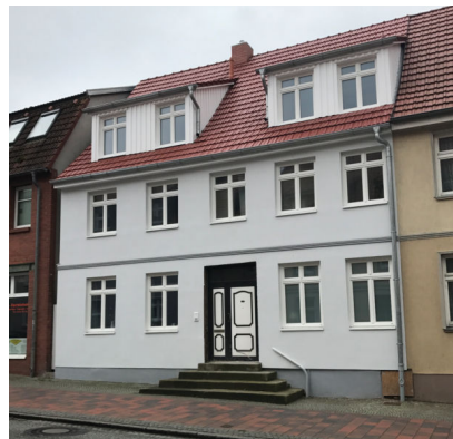
Lange Straße 90 (Sanierung 2016/2017)
