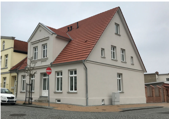
Südlicher Rosengarten 31 (Sanierung 2016)
