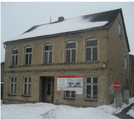
Lange Straße 73 (Rückbau 2011, derzeit Baulücke)
