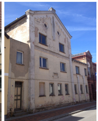
Mühlenstraße 8 (Abbruch 2016, Baulücke)
