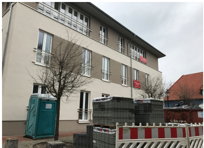
Alte Klosterstraße 16 ehemalige Hauptmannschule in Sanierung/Umbau (Fertigstellung 2017)
