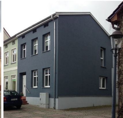
Grüne Straße 8 (Sanierung 2014)
